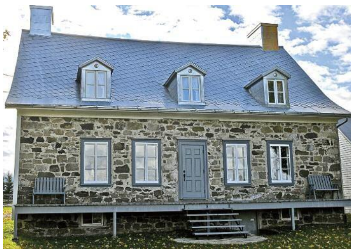
Le 231, route du Fleuve, Maison Labrecque (construite vers 1835).
