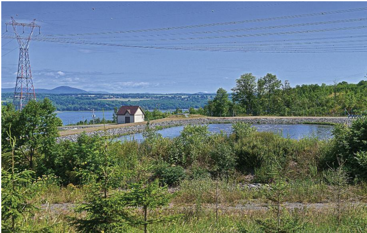
Bassin de la station d'épuration des eaux usées.
